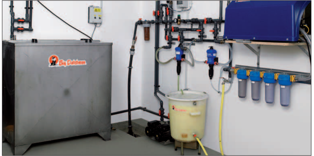
Подсобное помещение с мало- и крупногабаритными смесителями для медикаментов
